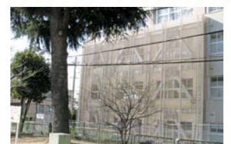
1号館東面外壁耐震補強工事▶
